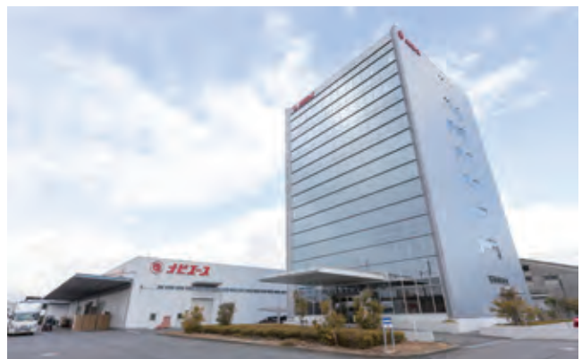
1963年、春日井市に本社・工場建設
